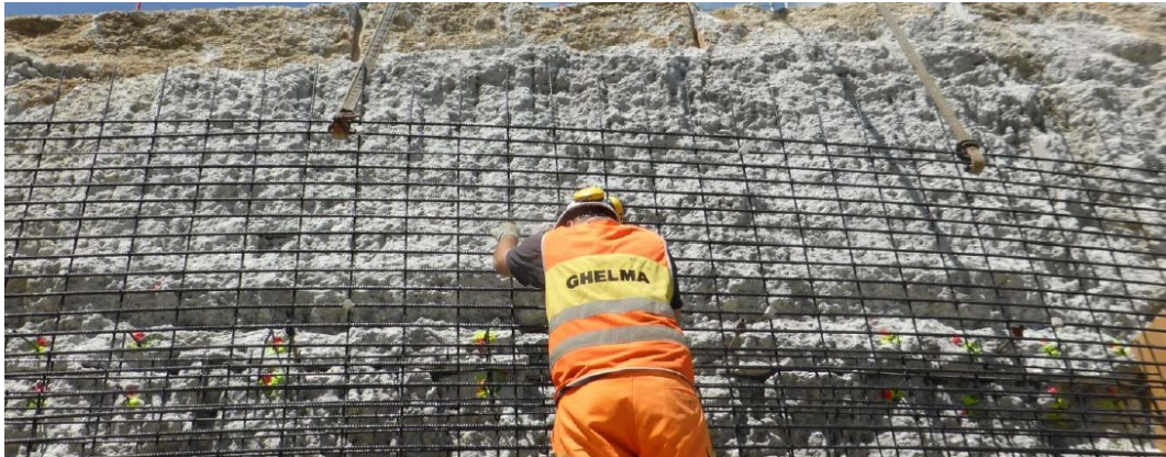
Abb. 3.7 Basaltfaser-Bewehrungsnetze zur Sanierung einer Stützmauer in Grindelwald, Bern. Fotos von Basalt Fibertec GmbH.
