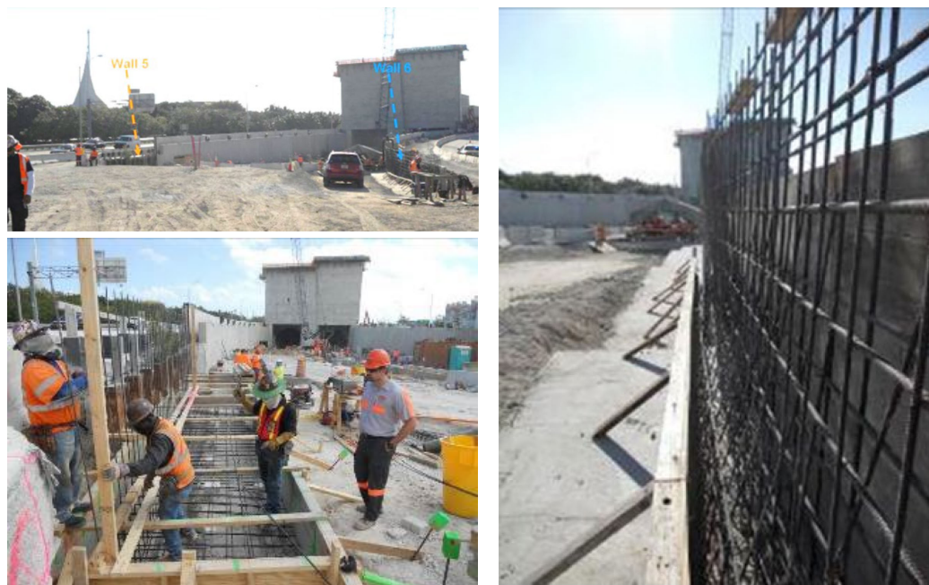
Abb. 3.11 Beispiel Stützmauer, Wand 5 und 6 mit Basaltfaser-Bewehrungen in Miami, Florida, (USA), aus [63].
